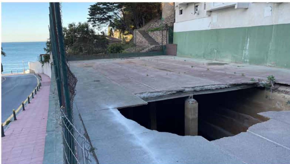
Mancomunidad anuncia la demolición del depósito de Cotobro en Almuñécar (EL FARO)
