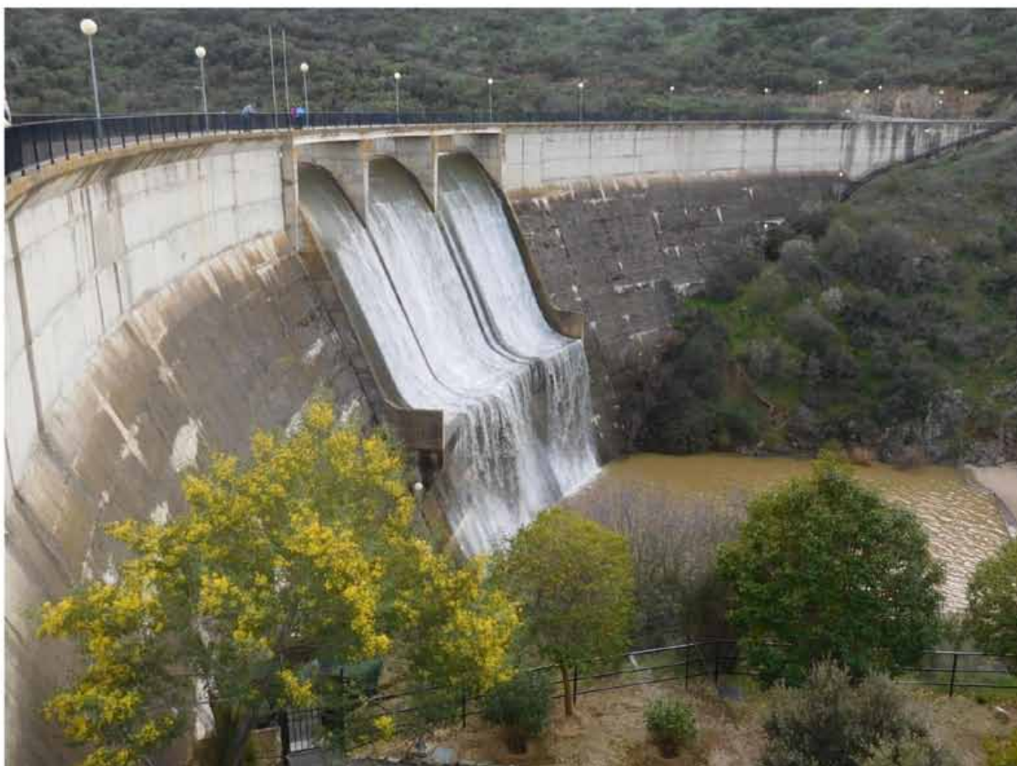
La presa de Fresneda desaguando (Ciudad Real)
