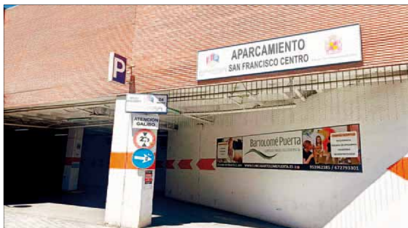
ARREGLO. Entrada al aparcamiento de San Francisco, ubicado junto al mercado.
