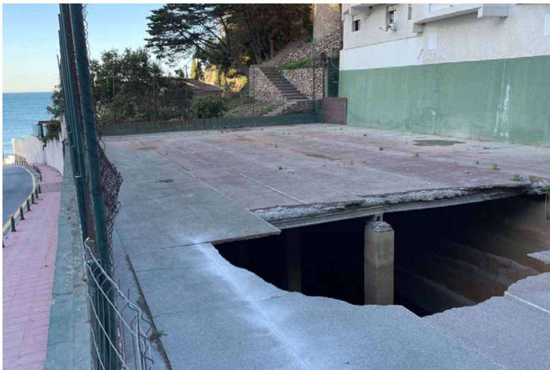
Demolición del depósito de Cotobro | Foto: Gabinete
